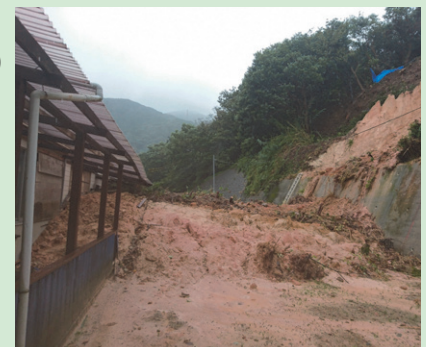
法面（斜面）の崩壊による被害
