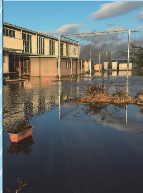
グラウンドへの浸水
