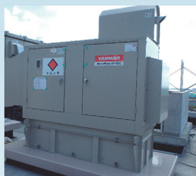
非常用発電機を屋上に設置
