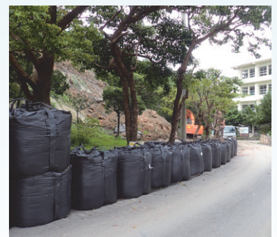
土のうによる応急対策
