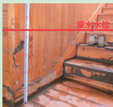
浸水水位の計測
