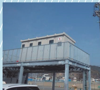
屋外キュービクルのかさ上げ
