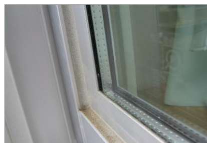
複層ガラスの設置 (新潟県長岡市立新町小学校)
