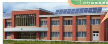
校舎屋上には太陽光パネルを、校舎内には発電量を確認できる大型パネルを設置 (北海道南富良野町立南富良野小学校)
