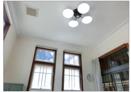
内壁や天井に改修前にも使われていた漆喰を採用（愛媛県伊予市立翠小学校）
