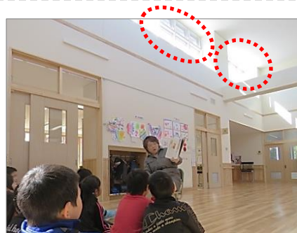
晴天時はハイサイドライト（高窓）による自然光だけで読み聞かせが可能（北海道南富良野町立南富良野西小学校）
