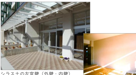
シラス土の左官壁（外壁・内壁）
