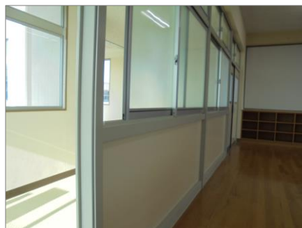
間仕切りの断熱化 (ペアガラス)
