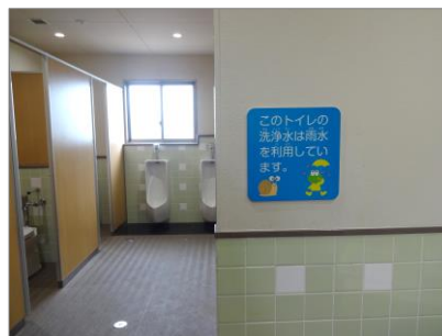
雨水を利用したトイレのサイン
