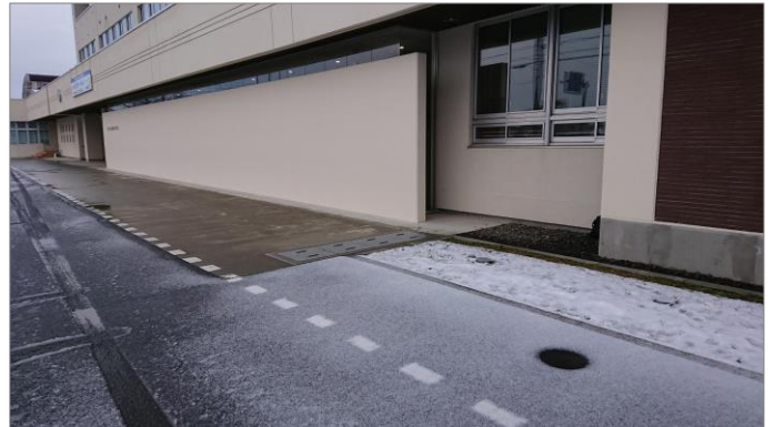
地下水の熱で融雪している様子
