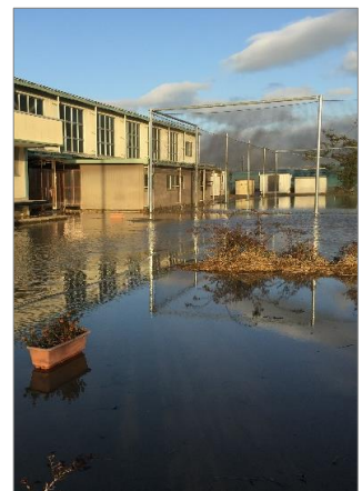
グラウンドへの浸水
