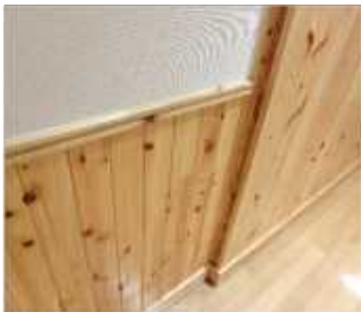
CLTに見て触れることができる壁
