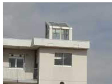
煙突効果で暖かい空気が上昇する仕組みを利用して自然換気を行う（福岡県北九州市立曾根東小学校）
