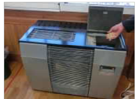
各室に設置されているペレットストーブFF式 (愛媛県伊予市立翠小学校)
