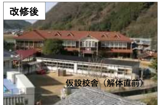
伊予市指定有形文化財を保全した耐震・エコ改修後の外観 仮設校舎（解体直前）
