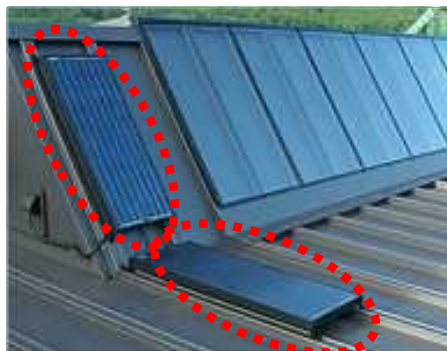
集熱器により暖められた外気を教室の床下に送風し、暖房に活用 (熊本県和水町立三加和小学校)
