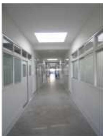
トップライトを設けた廊下
