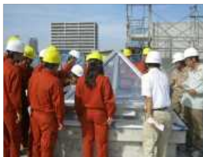
トップライトの建設現場勉強会（建築系学科）
