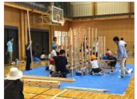
「木育わくわくひろば」で木のジャングルジムを組み立てている様子
