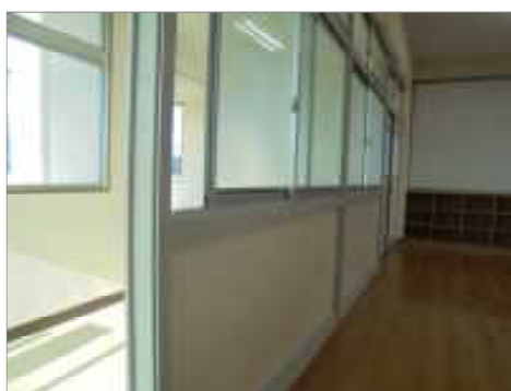
間仕切りの断熱化 (ペアガラス)
