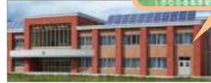
校舎屋上には太陽光パネルを、校舎内には発電量を確認できる大型パネルを設置 (北海道南富良野町立南富良野小学校)
