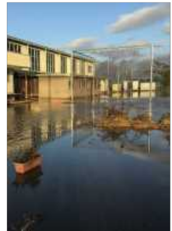
グラウンドへの浸水
