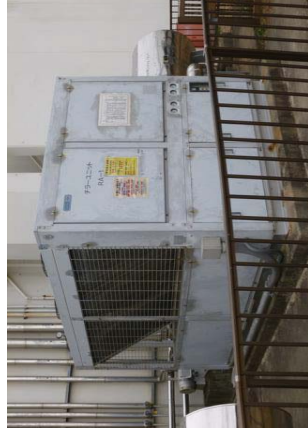
高経年化対策 低放射性固体廃棄物貯蔵場冷凍設備の更新 (核燃料サイクル工学研究所)
