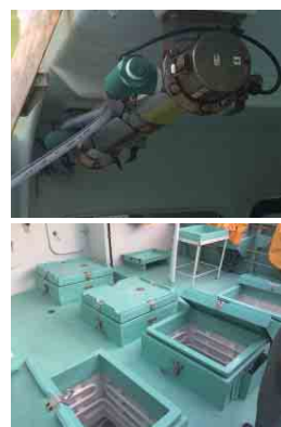
(上)船上紫外線殺菌装置 (下)船上殺菌水槽
