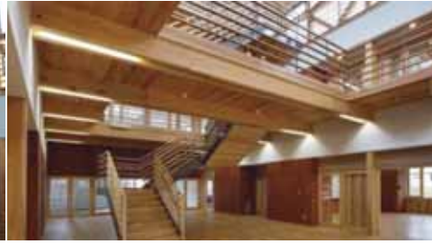
吹き抜けを利用した自然換気 8mのロングスパン
