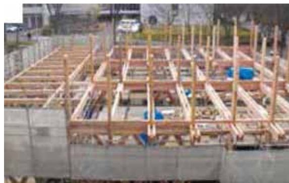
杉間伐材を利用した骨組み(建設中)
