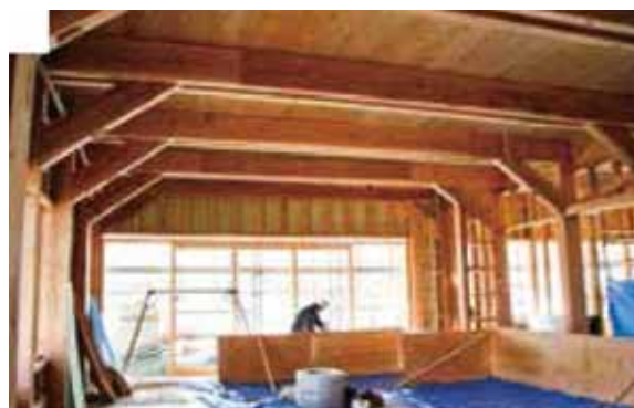
自然素材にあふれる講義室(建設中)
