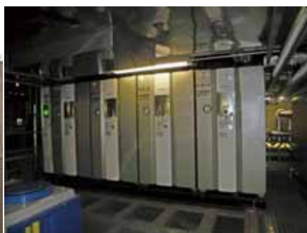
高効率小型貫流ボイラ(東病棟)
