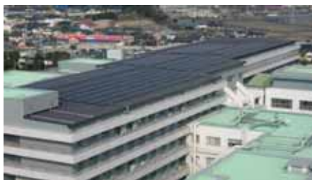
太陽光パネル
