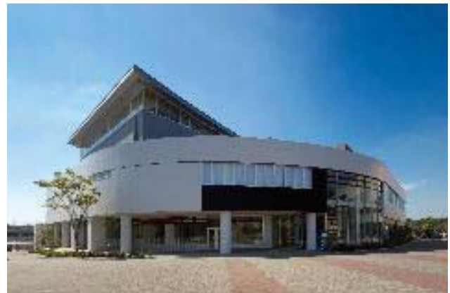
i プラザ外観（北東メイン入り口側）
