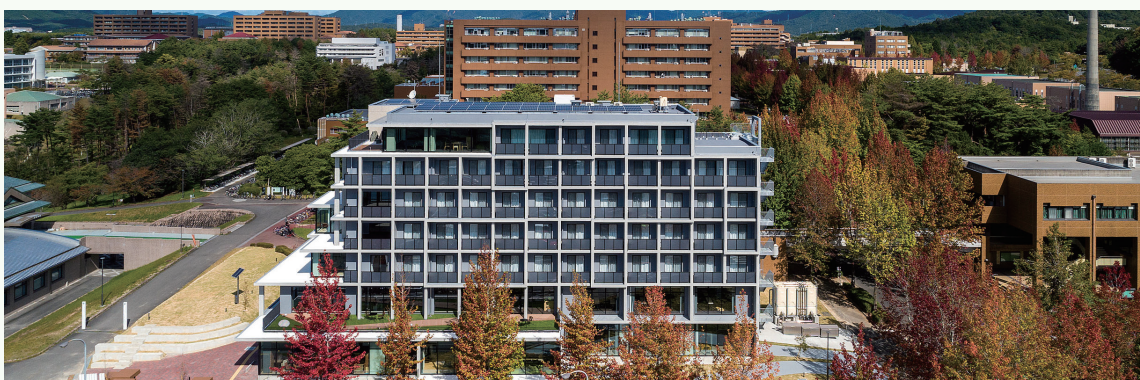
▲太陽光発電設備を設置した国際交流拠点施設（ミライクリエ）（2021年9月竣工）
