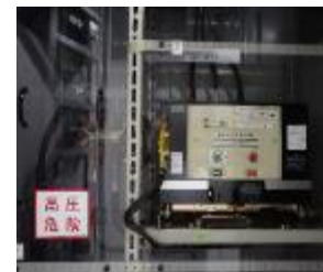
受配電設備の更新
