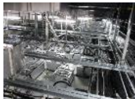
高 cleanliness 空調更新
