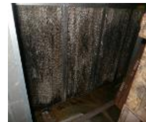
加湿器濾過材の整備
