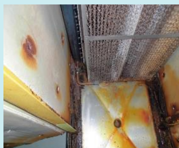
空調機器内部底面のフレーム部及び給気ファンの腐食等への対応
