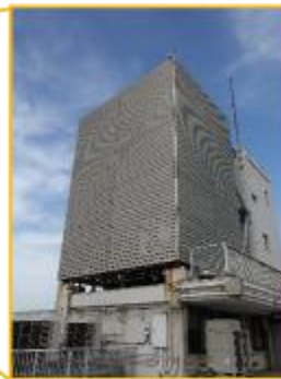
高架水槽の外観 (第1研究棟屋上)
