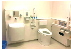
多機能トイレ等バリアフリー化により避難所としての防災機能を強化
