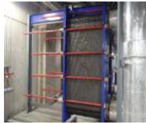
熱交換器の整備
