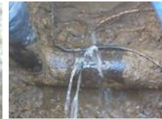
▲給水管からの漏水
