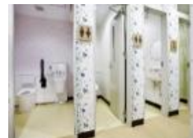
洋式化、乾式化された安全で清潔なトイレ
