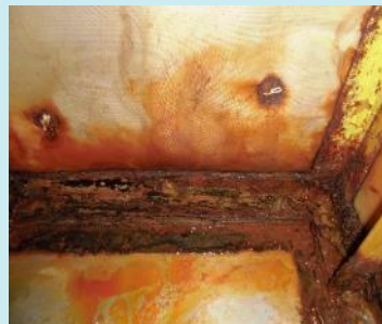
空調機器内部底面のフレーム部及び給気ファンの腐食等への対応
