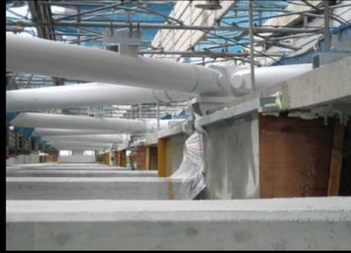
モルタル注入
