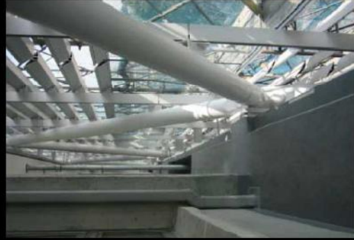
ルーバー付設
