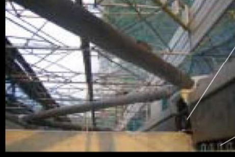
雨樋・空調用開口 ブレース建て方後 モルタル充填
