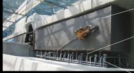
外部よりケミカル アンカー打込み シースタッド 鋼製梁
