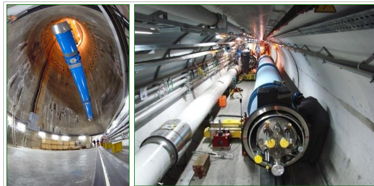
図 42 一つの縦坑から装入された低温磁石と狭いトンネル内での取り回し
