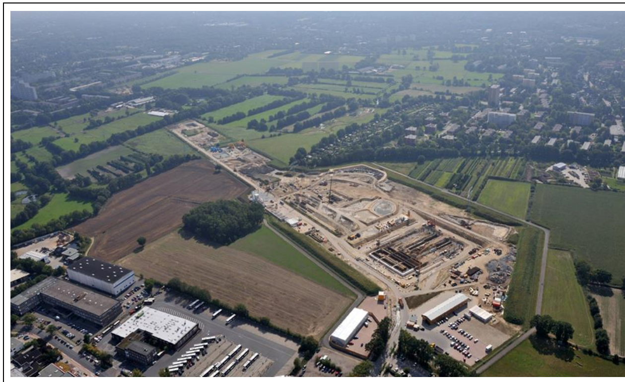
図 75 並行して実施された地上工事の様子
