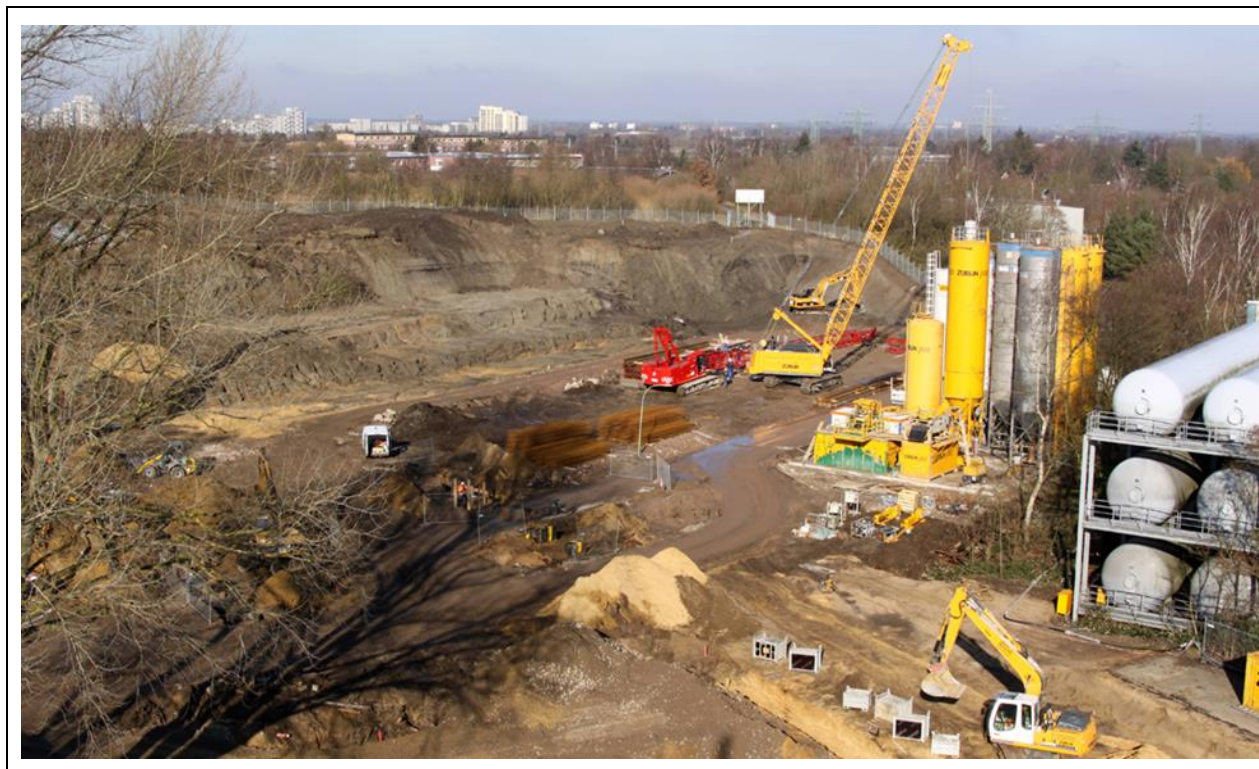
図 72 土木工事の様子(造成)
