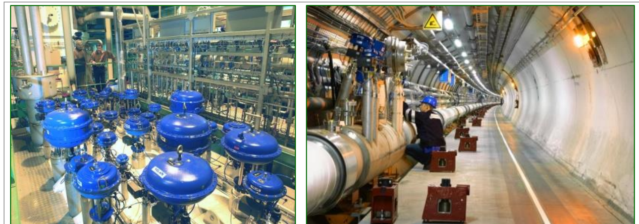
図 41 順調に工事が進んだ低温装置の設置(左)と難工事となった冷媒分配パイプラインの設置
