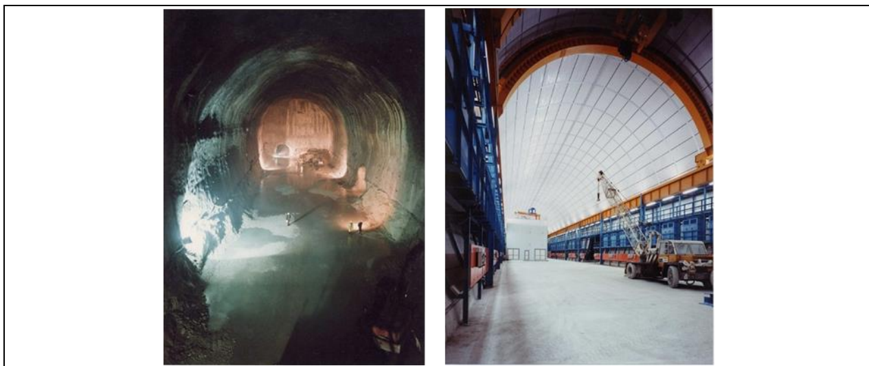
図 80 LNGS のトンネル建設風景と建設後の写真
