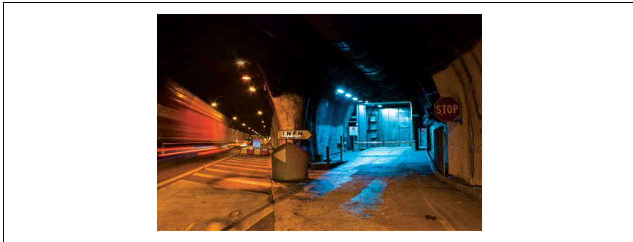
図 79 A24 Teramo-Rome Highway)と LNGS の入り口
