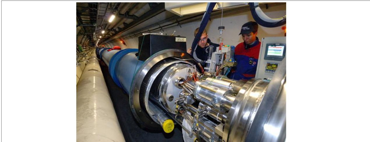
図 43 低温磁石の接続部分の工事の様子
