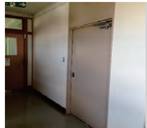
階段前に扉を設置し施設を分離
