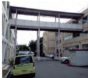
二つの棟の3階部分を繋ぐ渡り廊下
