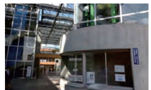
小学校のテラスと図書館の入口が近接する2階には警備員が常駐
