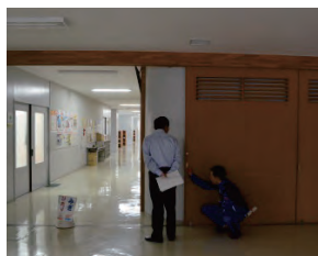
学校開放部分とそれ以外の部分を区分する扉
