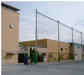
新BOP室の入口は校庭側に設けられている
