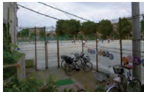
中学校部分とはフェンスで区分し、上部に防球ネットを設置
