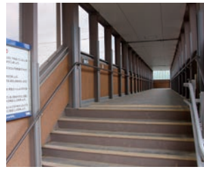
連絡通路内部
