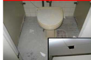
■床スラブ 経年31年 上階の便器固定用モルタルの落下により、天井を突き破り床まで落下。
