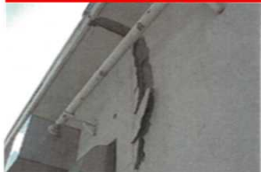
■外壁 経年46年 外壁が経年劣化により亀裂を生じ剥落。
