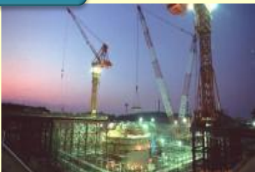
原子炉格納容器の設置
