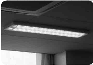
図4 照明の反射防止対策の例
