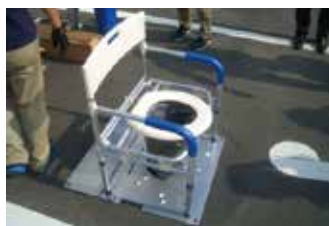
屋外に設置したマンホールトイレ (東京都北区十条富士見中学校)
