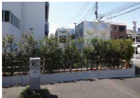
地震発生時には濁った水が入ってこないように 受水槽のバルブを閉め、飲料水として使用 (東京都江戸川区立松江小学校)
