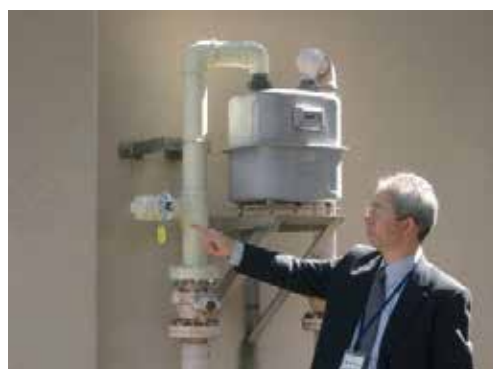
都市ガスエリアにおいても災害時には LP ガスを使えるよう、LP ガス変換器の接続口を整備 (長岡市教育委員会提供)
