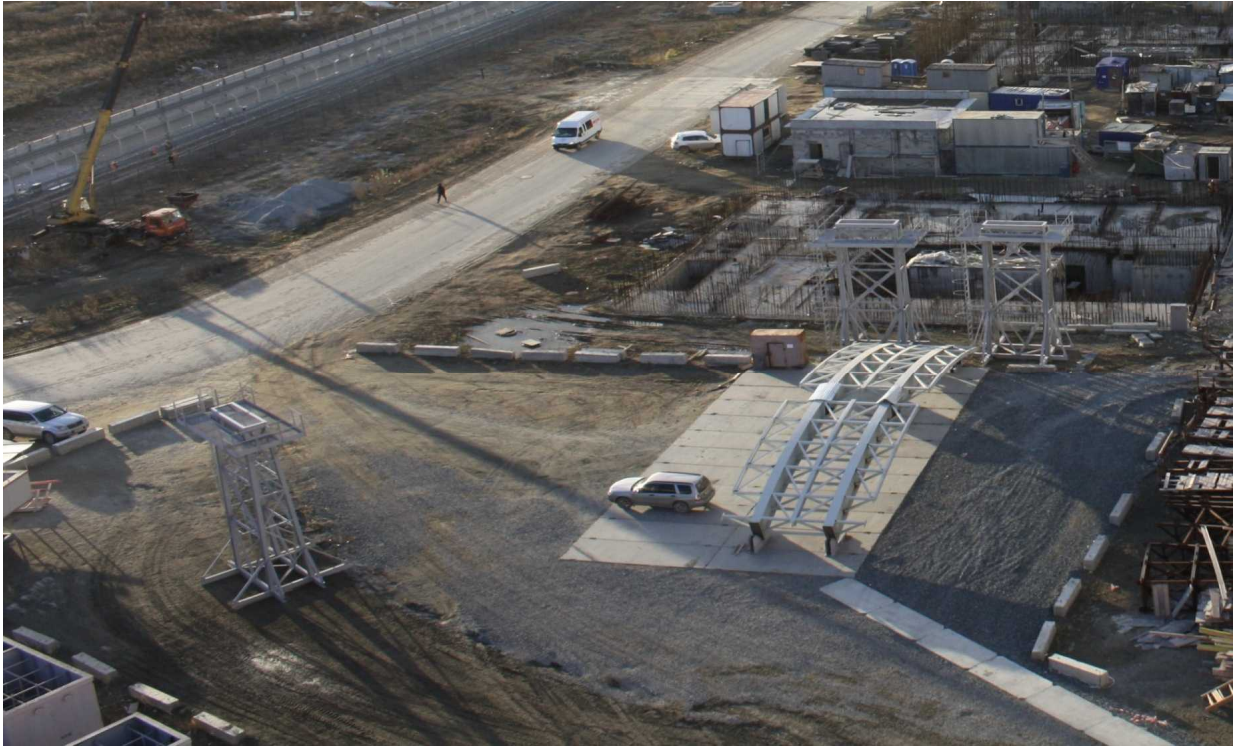
原子炉隔離室用金属製天井部の組み立て作業場の鳥瞰写真 (2012年10月30日) Tsuruga, Japan, April 24-25, 2013
