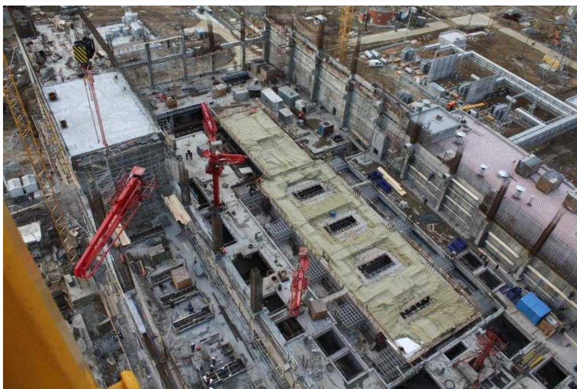
タービンホールの鳥瞰写真。タービン発電機床のコンクリート打設 (2012年10月30日) Tsuruga, Japan, April 24-25, 2013
