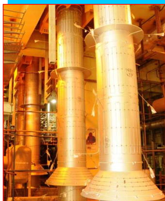
蒸気発生器全機設置
