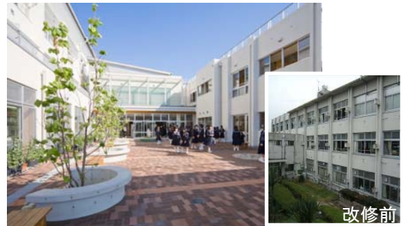
環境に配慮した学校施設として再生
