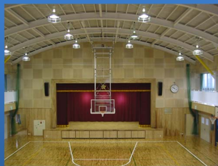
屋内運動場を地域の防災拠点 として再生した事例
