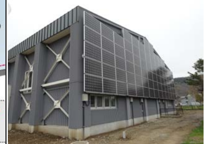
図7 屋内運動場の壁面を利用した太陽光発電パネル
