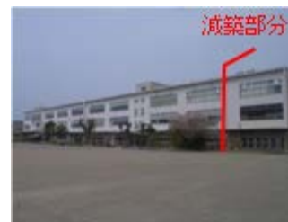
図3 改修前の校舎
