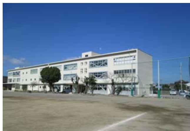
図4 減築後の校舎
