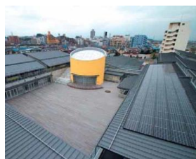
屋根に太陽光パネルを設置 〔東京都多摩市立多摩第一小学校〕
