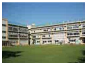
校庭を芝生化し、壁面を緑化 〔東京都杉並区立杉並第七小学校〕
