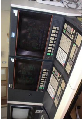
高経年化対策 JRR-3運転制御用プロセス計算機の更新 (原子力科学研究所)
