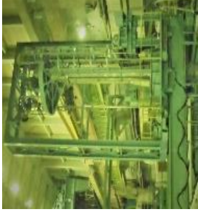
高経年化対策 燃料取出しプールクレーンの更新 (核燃料サイクル工学研究所)
