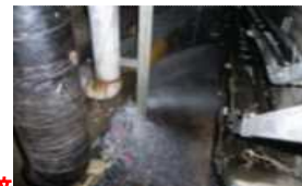
配管の破損による水漏れ
