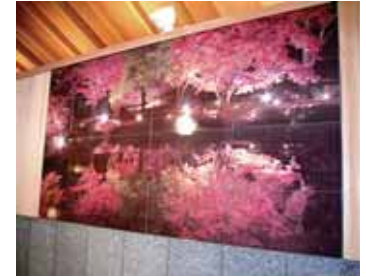
バーデンパークSOGI(土岐市曾木)施設内の壁面に施工された壁装タイル(2流体方式)
