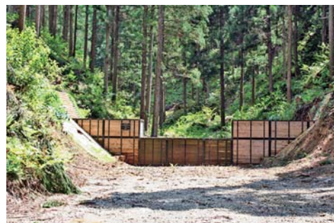
ハイブリッド木製ダム
