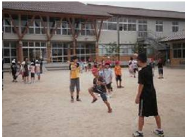
地域材を利用した温かみのある木造一部二階建て校舎
