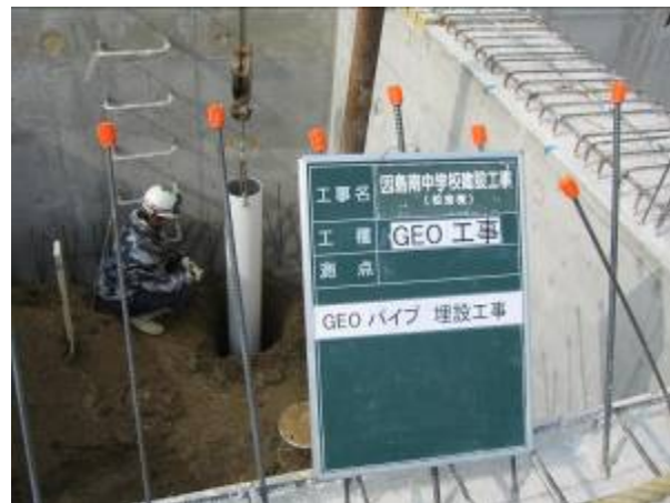
地中熱換気システム用パイプの埋設工事
