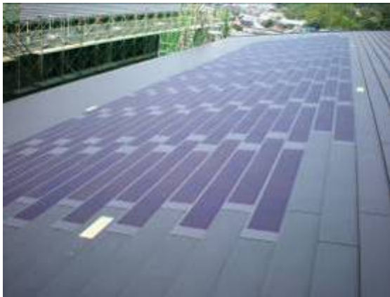
屋内運動場の屋根に太陽光発電パネルを設置
