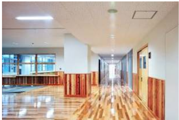
校舎の内装に間伐材を利用
