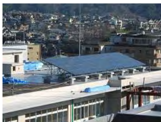
生駒中学校改築工事のようす
