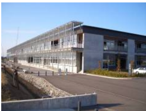
日射調節のために設置したルーバー
