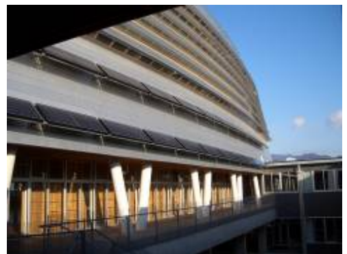
太陽光発電（体育館屋根部）
