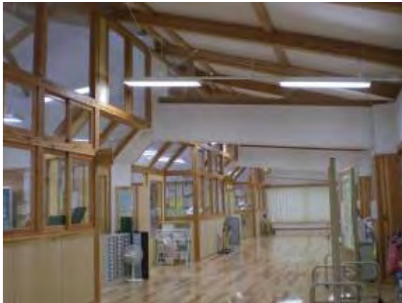
小屋組みに使用した大断面集成材
