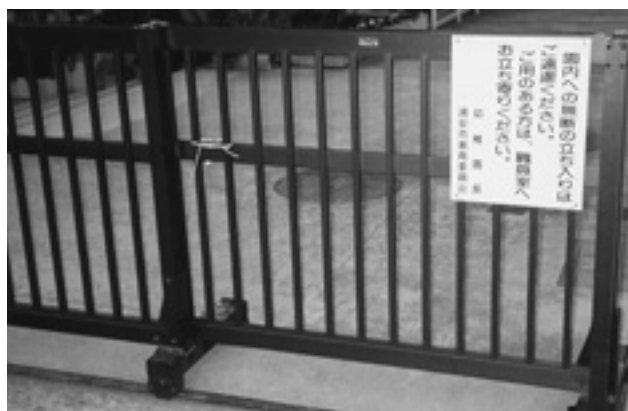
【閉門時の門扉及び施錠】
