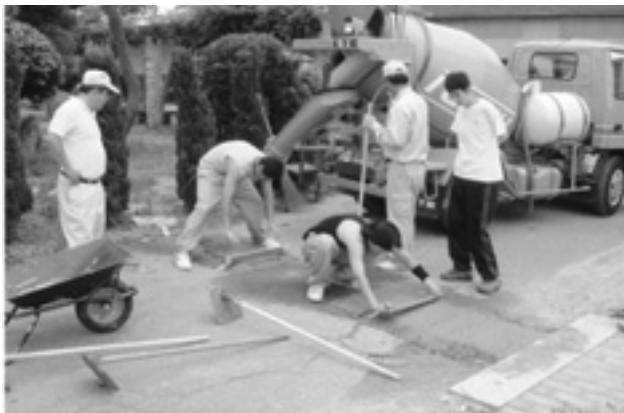
写真一 2 生徒による施工実習
