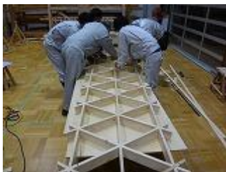
図8 組子壁製作の様子
