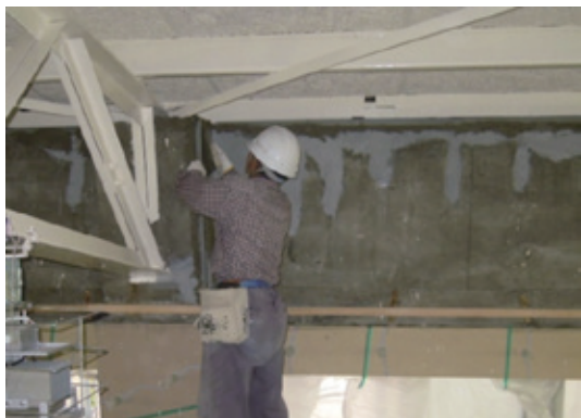
樹脂モルタル充てん中
