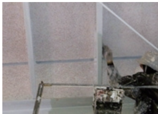
防錆塗料の塗布
