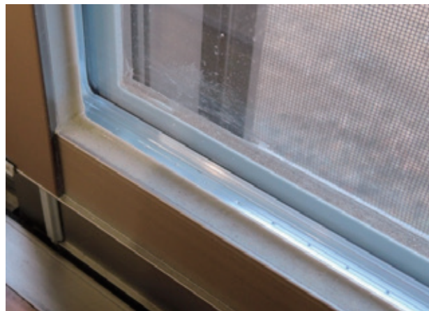
断熱性の向上のため複層ガラスを使用
