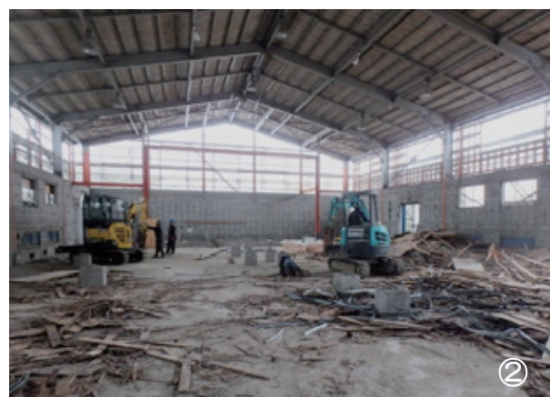
写真 ①既存体育館の鉄骨骨組みのみ残した状態 ②既存体育館の鉄骨骨組みのみ残り解体中 ③屋根材、外壁材、内装材等の改修中
