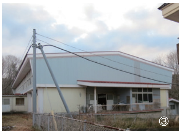
写真 ①外観（改修後）②内観（改修後）③外観（改修前）
