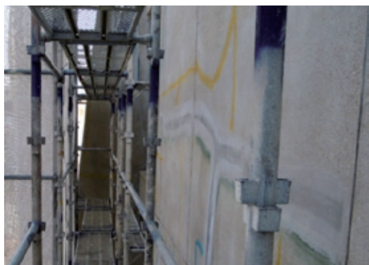
施工前（ひび割れ補修後）
