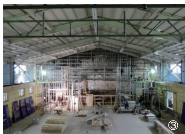
写真 ①既存体育館の鉄骨骨組みのみ残した状態 ②既存体育館の鉄骨骨組みのみ残り解体中 ③屋根材、外壁材、内装材等の改修中
