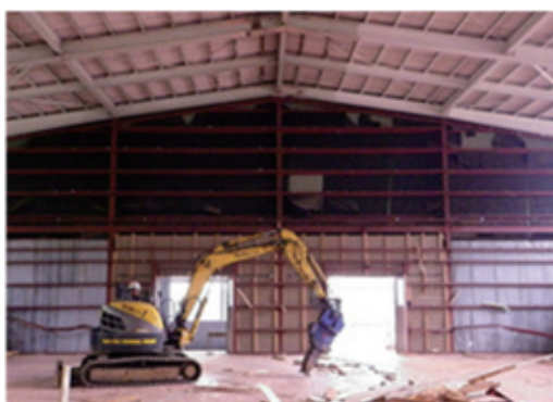
既存屋根材及び鉄骨骨組み以外を解体
