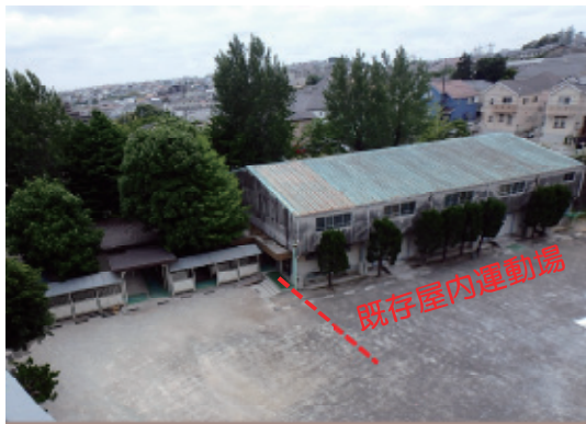
老朽化した屋内運動場
