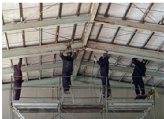
腐食部分の除去
