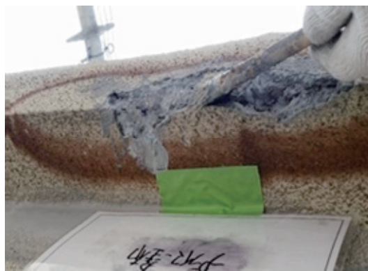
モルタルの付着を良くするための下地材を塗布
