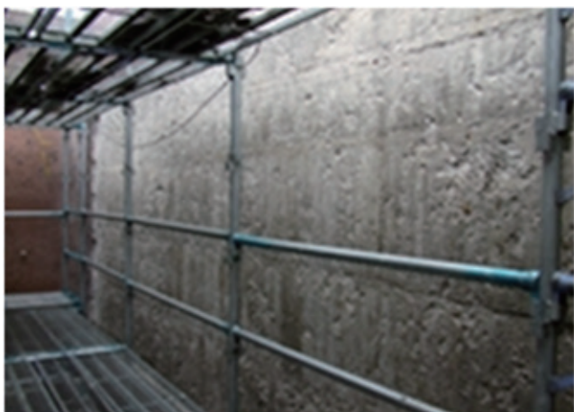
外壁の仕上げモルタル撤去後
