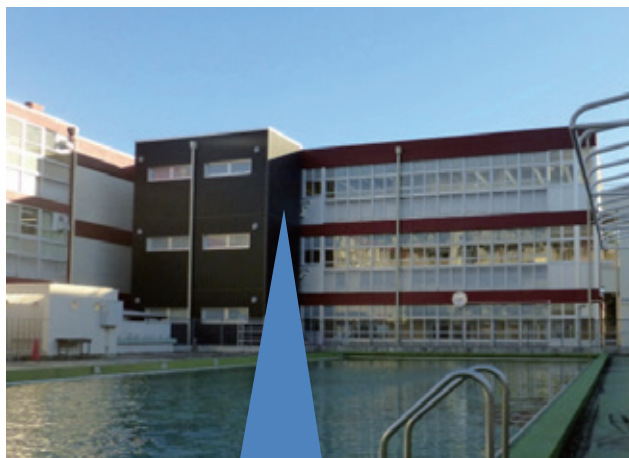
外装にガルバリウム鋼板新設
