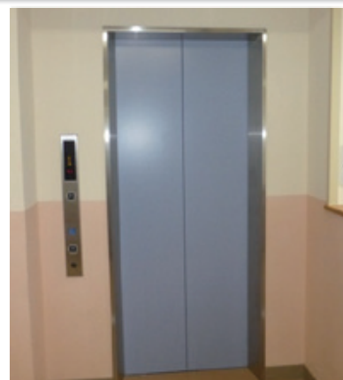
エレベータ設置
