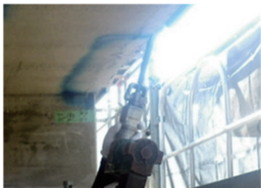
鉄筋が露出している部分をはつり取る作業
