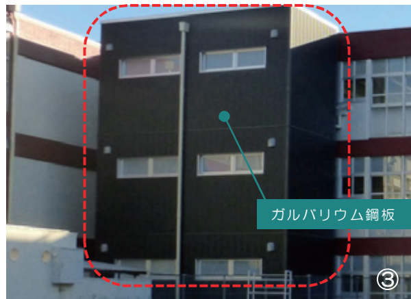
写真 ①外観（改修後）②外観（改修前）③外装にガルバリウム鋼板新設
