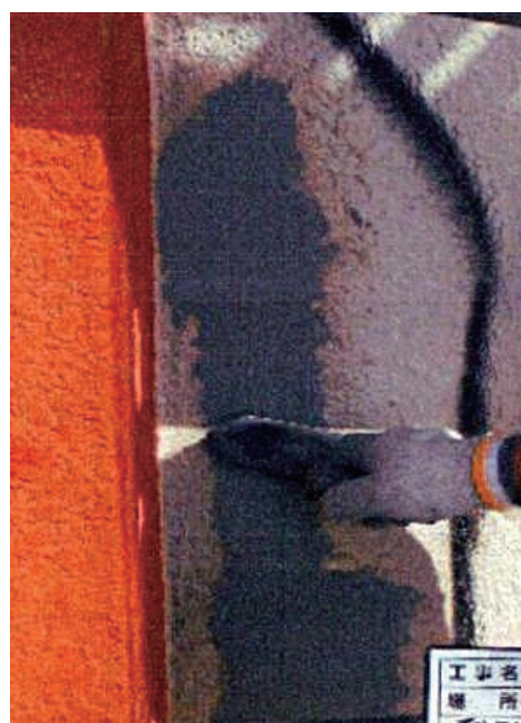
エポキシ樹脂モルタル充てん仕上げ
