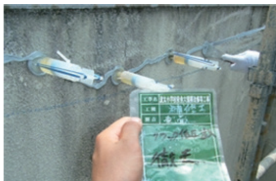
注入器具を用いてひび割れ部に注入材を充てん
