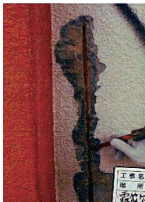
鉄筋が露出している部分をはつりとした状態
