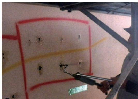
アンカーピンとモルタルを躯体に固定するためエポキシ樹脂を注入
