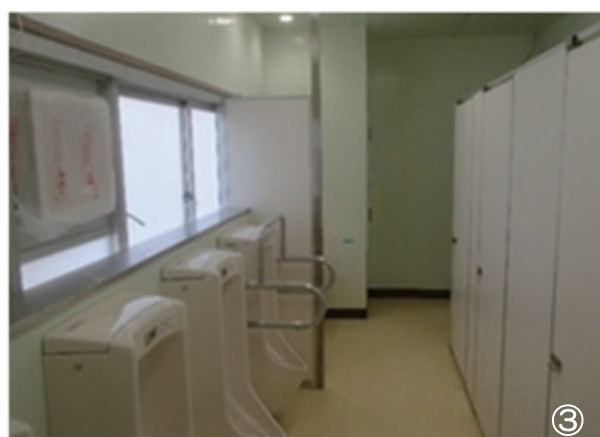
写真 ①外観（改修後）②外観（改修前）③トイレ（改修後）
