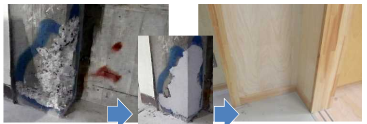
構造区体の部分的な欠損に対する改修
