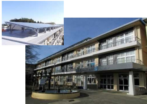
福島県 矢吹町立矢吹小学校
