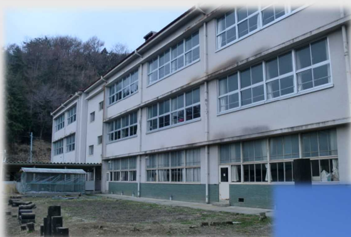
大規模改造工事 前
