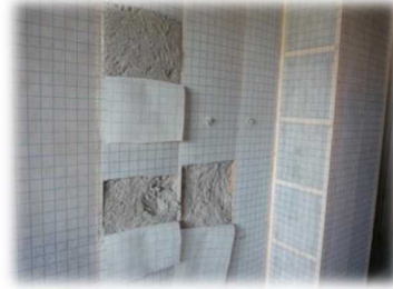
古新聞由来の断熱材 セルロースファイバー (デコス/株デコス)
