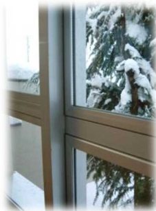
ペアガラスの採用 アタッチメント工法
