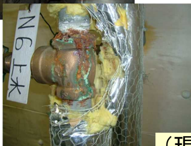
給水管継ぎ手の劣化状況
