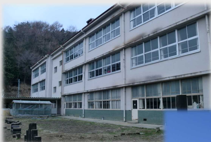
大規模改造工事 前
