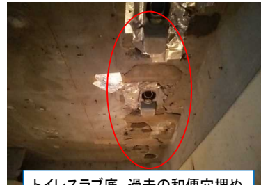
トイレスラブ底 過去の和便穴埋め 補修がずさん。 落下の恐れがあるので、調査をし 適正補修を行う
