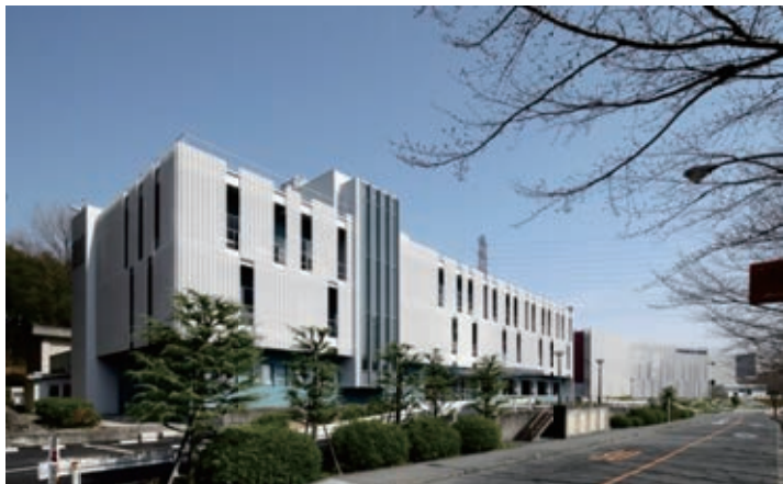
西側外観（手前：本館，奥：IIコア棟）
