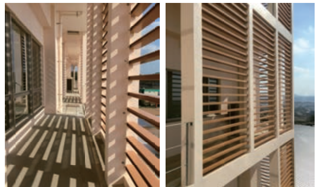
広めの点検用バルコニーとルーバー（3階～6階）
