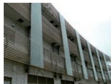
将来の機器更新と避難安全性を両立するメンテナンスバルコニー
