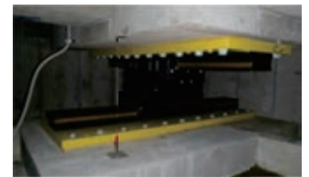
BCP 対応として免震構造の採用
