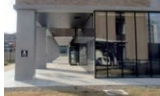
災害時の外部活動を支援する回廊スペース
