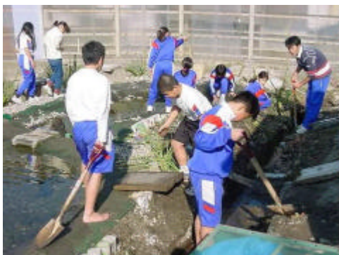
「トミヨの里ミニ広場」建設中
